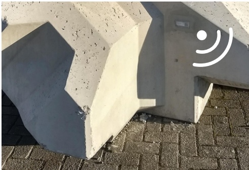
Levvel-bloc met ingegoten RFID-tag die de productinformatie bevat.
